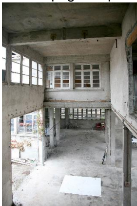
Figure 21: La friche Audevard, avant réhabilitation (Sainte Livrade-sur-Lot), source : Compagnie Architecture, 2025
